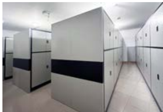
新安装的库房柜架
